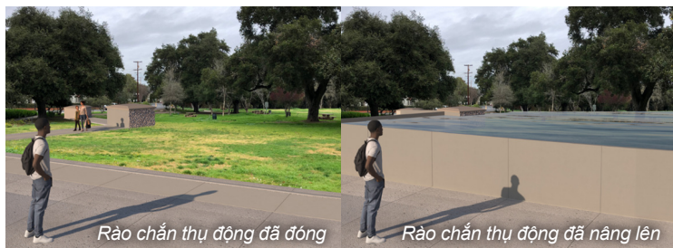
Tại Công viên Williams Street, nằm dọc theo South 16th Street, có kế hoạch xây dựng một rào chắn thụ động mà khi hoàn thành, rào chắn này sẽ giữ nước lũ trong công viên và ngăn nước tràn vào khu dân cư xung quanh.
