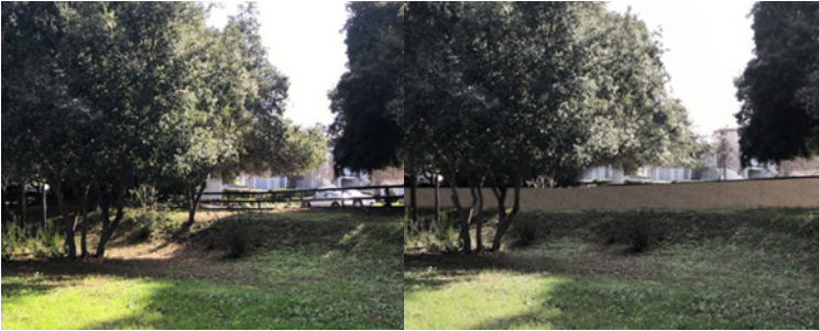
Các hoạt động của dự án bao gồm xây dựng một tường ngăn lũ trên đỉnh dốc dọc theo khuôn viên Công viên Kelley của thành phố.
