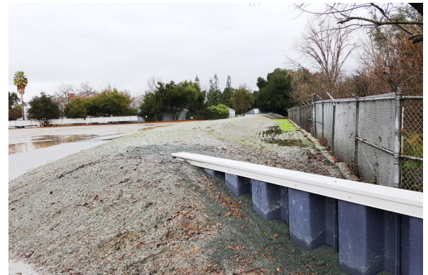
Detrás de los vecindarios de Nordale y Rock Springs, se instaló un tipo de barrera contra inundaciones conocida como terraplén para reducir el riesgo de futuras inundaciones.
