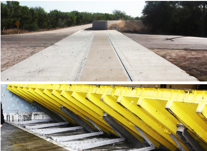
(Arriba) Una barrera instalada en estado empotrado. (Abajo) Una barrera pasiva en proceso de apertura.
