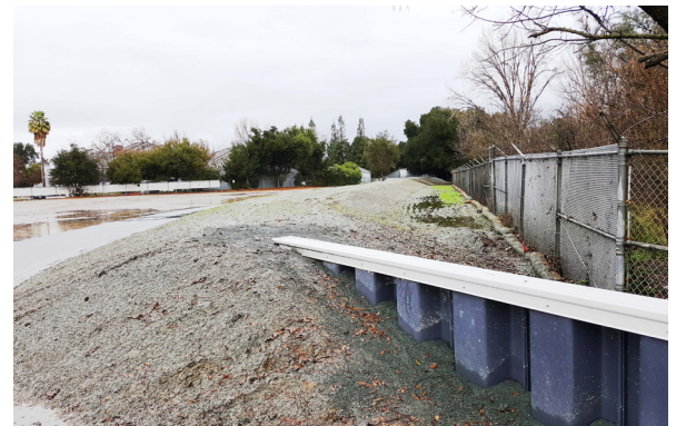
Một loại rào chắn lũ hay còn gọi là bờ đất được lắp đặt tại khu Nordale và Rock Springs để giúp giảm các nguy cơ lũ lụt trong tương lai.
