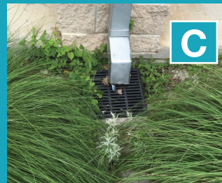
Desagüero desviado hacia un bajío mediante la cuenca de captación y la tubería subterránea.
